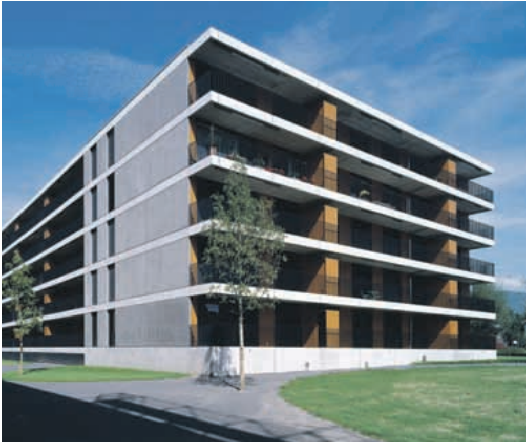
bonacasa®-Überbauung Schüsspark in Biel
