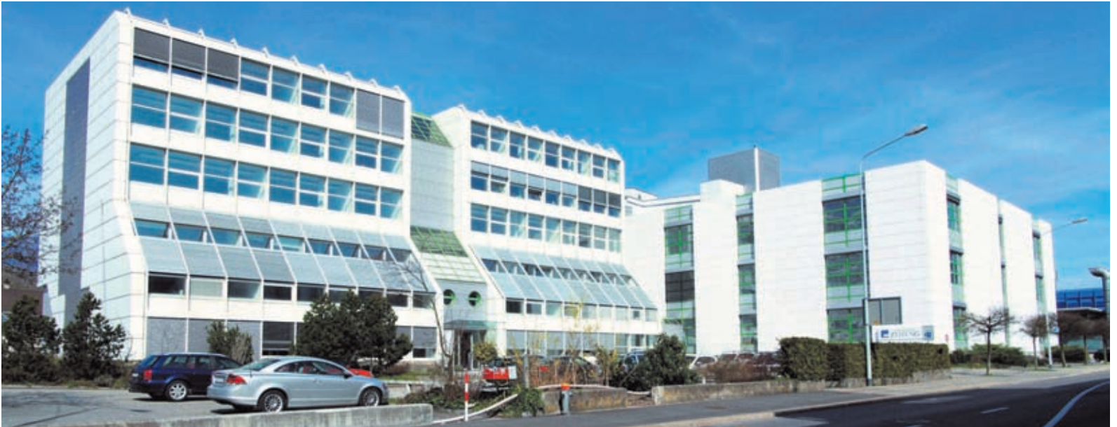
Starke Präsenz im Herzen der Schweiz: Das medienhaus solothurn bietet grosse Büroräume in moderner Architektur an zentraler Lage.
