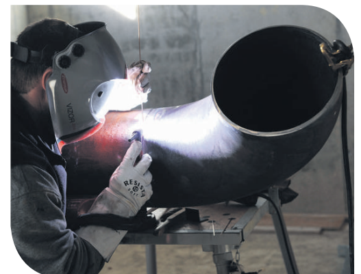
Die Spezialisten der Regio Energie schweissen die Rohrleitungen «in Form».
