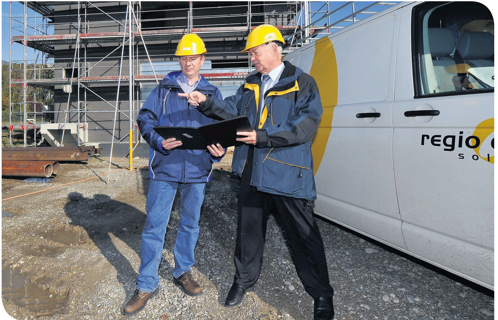
Projektleiter Marcel Rindlisbacher (l.) und Felix Strässle, Direktor Regio Energie Solothurn, besprechen auf dem Aarmatt-Areal die Baufortschritte.
