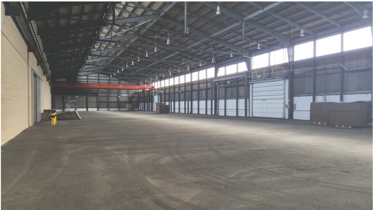
Innenansicht: renovierte säulenfreie Industriehalle
