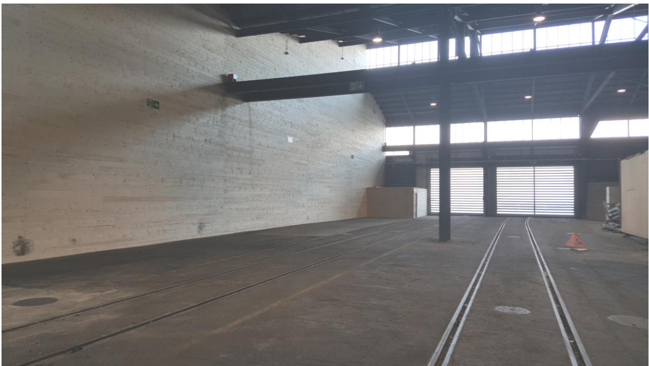
Innenansicht: Rolltor und Brandschutzabtrennung
