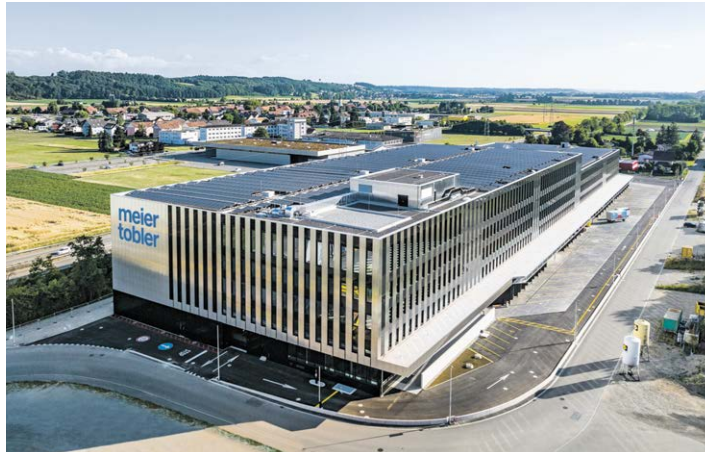
Das neue DCO, fotografiert aus der Luft von Ost nach West. Auf dem Dach das 2 MW peak Solarkraftwerk.
